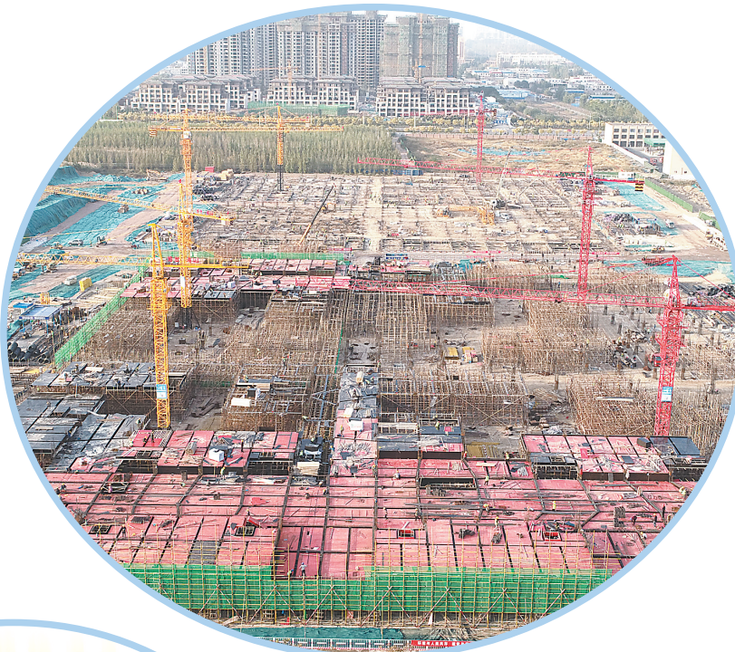
▲目前我市最大规模科技产业综合体焦作创基智谷，从9月15日大型挖掘机进场施工，到10月15日完成基础施工，如今地面建筑已建到2层，创下示范区科技综合体建设速度新纪录。图为施工现场。
