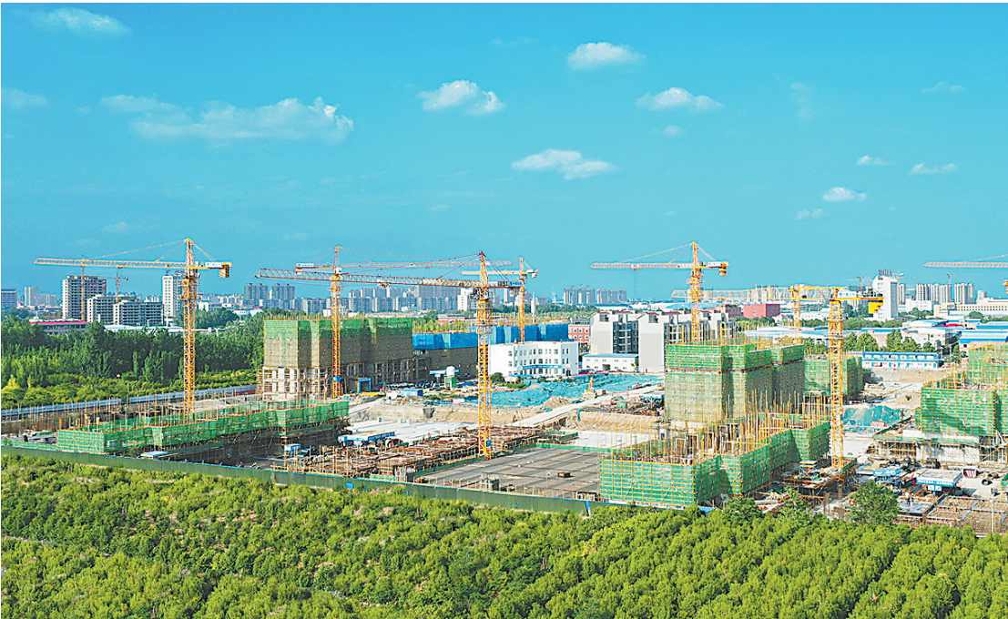
5月23日，示范区安置社区在建项目沁苑社区施工现场，塔吊在调运建筑材料，一派繁忙的施工景象。示范区城中村改造涉及5个社区的8个项目，现已开工7个项目，累计完成投资11.8亿元，目前相关项目的53栋楼已封顶。
