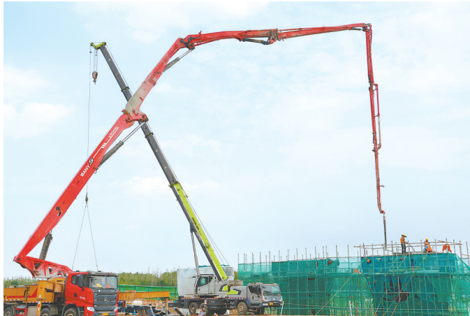
6月29日，山阳路（南海路—黄河大道）建设项目大沙河桥施工现场，建筑工人在有序作业。该项目总投资2.12亿元，其中大沙河桥投资1.58亿元，预计明年9月份通车。
